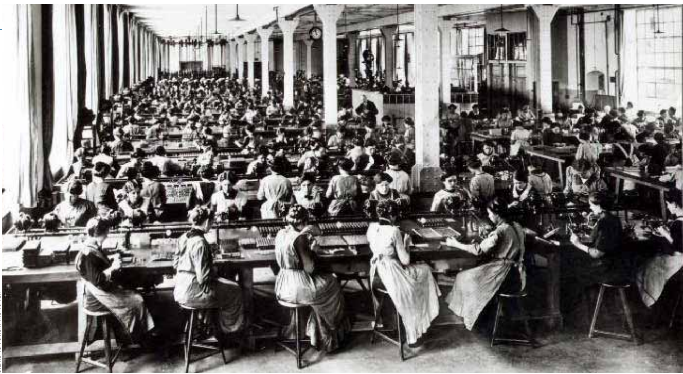
Fabrikarbeit bei Siemens in Nürnberg (um 1912)*: Lange Zeit nur bescheidene Renditen für die Geldgeber
